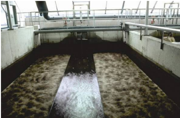
Figuur 33: terugspoelen van een snelfilter.
