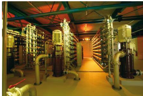
Figuur 35: anaerobe nanofiltratie voor de drinkwatervoorziening van Zwolle (Overijssel).
