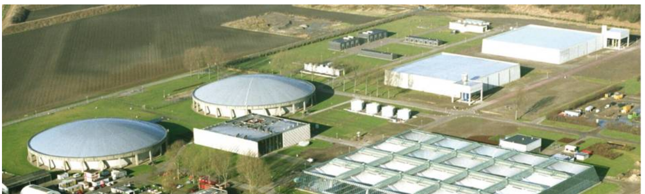
Figuur 44: de ronde en vierkante reservoirs van de productielocatie Berenplaat (Zuid-Holland).
