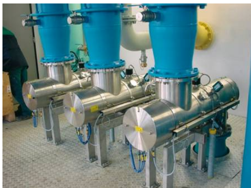
Figuur 40: Uv-desinfectie na actief-koolfiltratie bij oeverfiltratie in Heel (Limburg).
