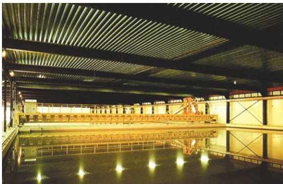
Figuur 34: langzame zandfiltratie Weesperkarspel (Amsterdam).
