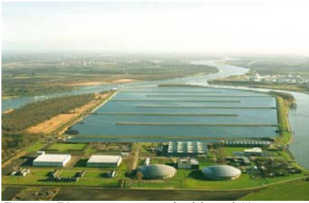
Figuur 52: propstroombekkens bij productiebedrijf Berenplaat (Zuid-Holland).
